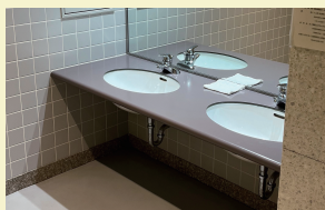
洗面台に車いすの車輪が当たらないため使用しやすい（新宿コズミックスポーツセンター）（地下1階男子更衣室）
