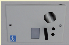
「向かって右側が車いす専用トイレです」などの案内をしてくれる人感センサー付き音声案内装置（東京体育館）
